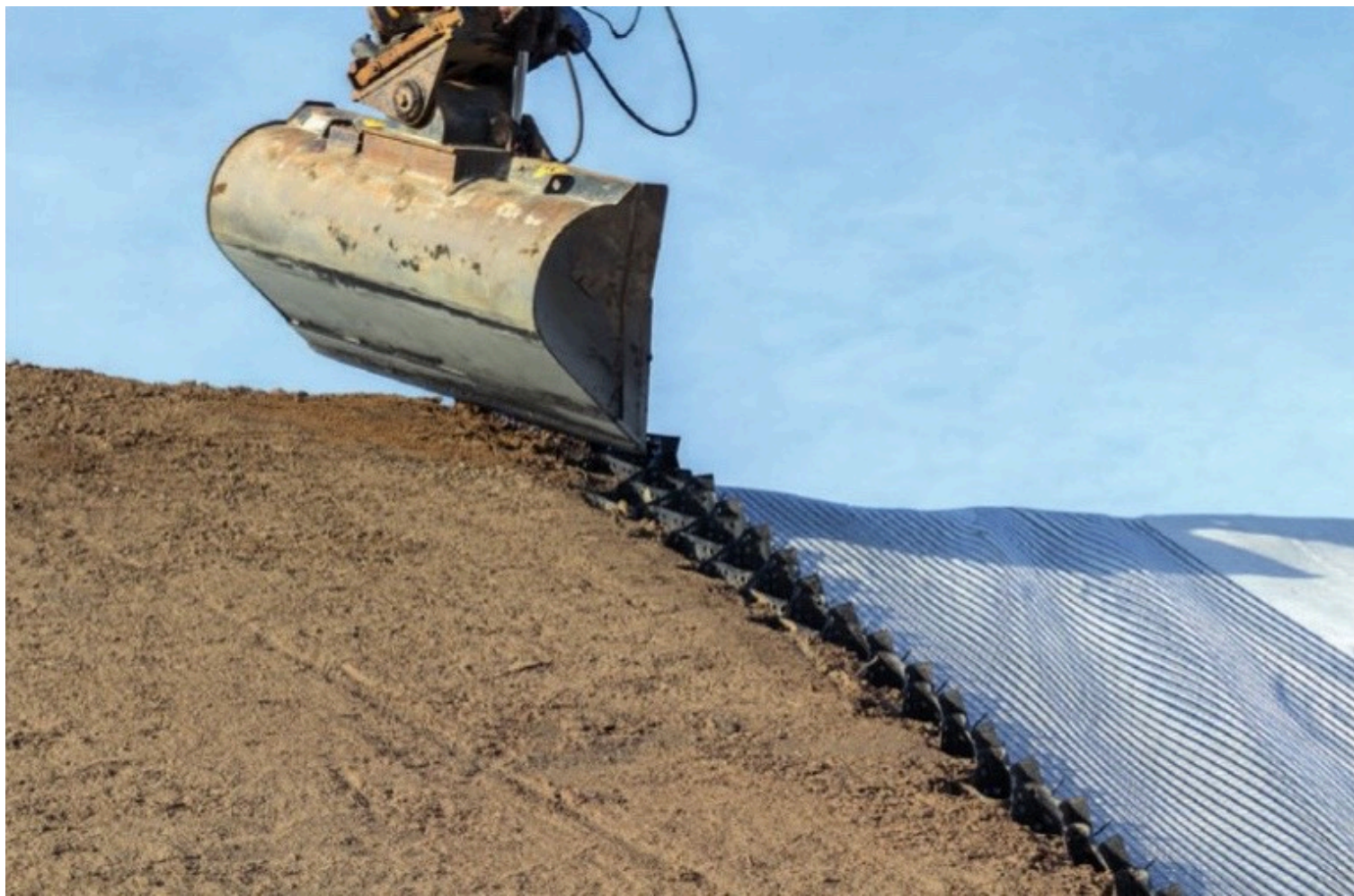
Ricoprimento delle geocelle
